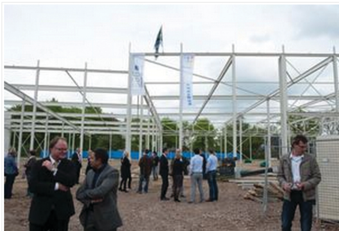
Op de bouwplaats werd het hoogste punt gevierd. foto Hans van de Vlekkert
